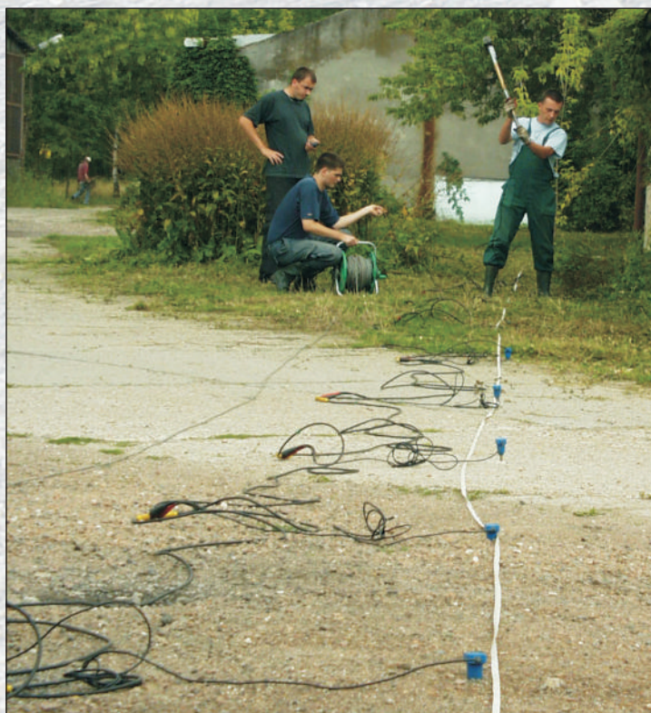
▲ Pomiar sejsmiczny w celu rozpoznania geotechnicznego dla celów projektowych budownictwa
