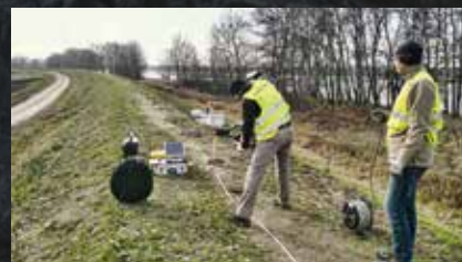
Obwałowania Wisły, Płock – badania sejsmiczne ciągłości przesłon przeciwnieprzepuszczalnych DSM
