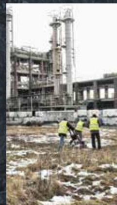
Zakłady Solveco S.A. – badania georadarowe w celu inwentaryzacji obiektów podziemnych
