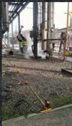
Tlenownia AirLiquide – badania sejsmiczne w rejonie zagrożonym osiadaniem
