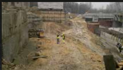
Nowe Muzeum Śląskie Katowice – badania sejsmiczne w rejonie głębokiej eksploatacji węgla kamiennego
