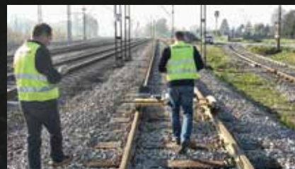
Śląski szlak kolejowy – badania georadarowe w rejonie modernizacji fragmentu linii
