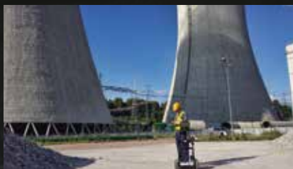
PGE Elektrownia Turów – badania georadarowe w rejonie budowy nowego bloku energetycznego
