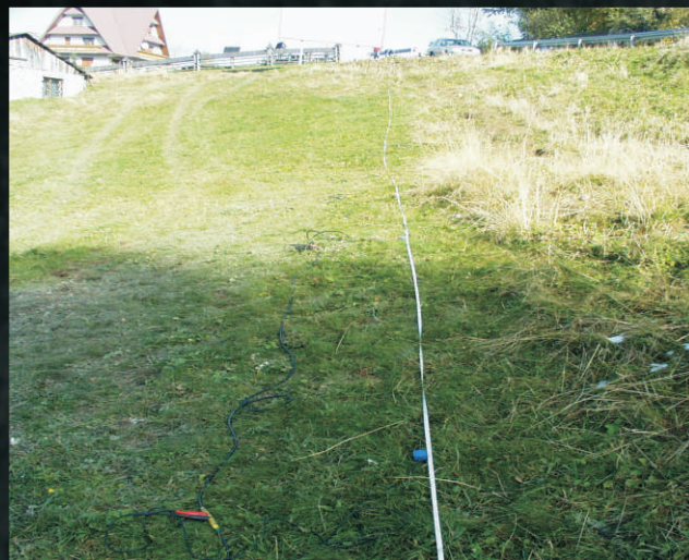
Pomiar sejsmiczny zbocza przy drodze w celu dokładnego wyznaczenia granic litologicznych.
